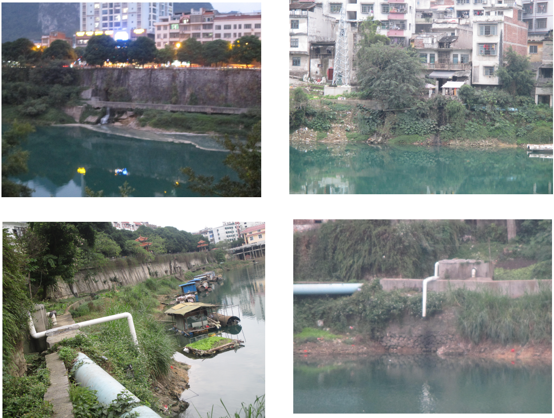
图 3.4-1 龙江一桥—九龙桥北岸现状生活污水直排口
