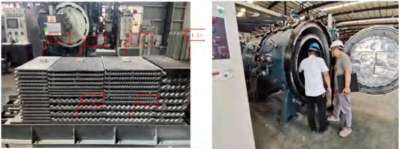
在某硬质合金生产线现场进行烧结炉在线原位校温试验
